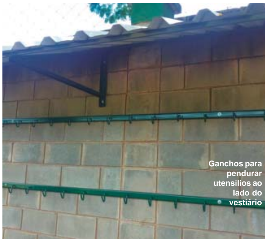
Pintura em vários pontos
